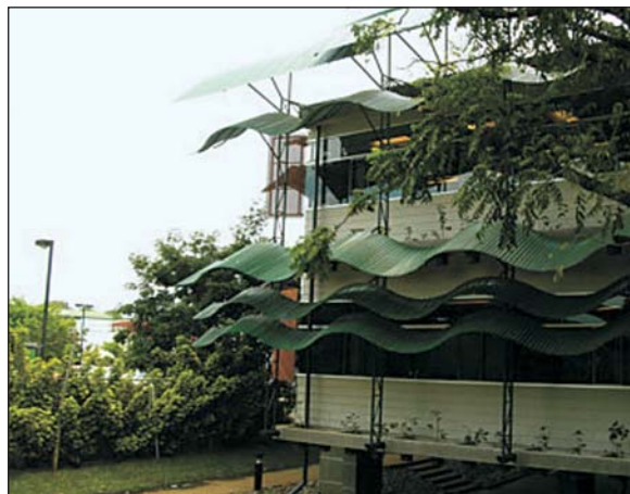
Figura 51: Exemplo de sombreamento. Edifício BAT. Arquiteto Bruno Stagno Costa Rica Fonte: www. brunostagno.info (imagem cedida pelo autor).
