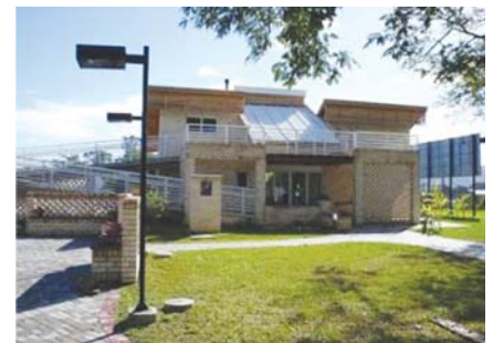
Figura 5: Elementos vazados como redutores de velocidade do vento sul. Projeto Casa Eficiente. Florianópolis (CASA EFICIENTE) Foto de LabEEE/UFSC (imagem cedida pelo autor).
