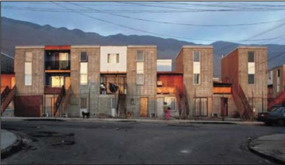
Figura 15: Projeto residencial Quinta Monroy. Iquique Chile. Possibilidade de expansão das casas pelos moradores até 70m 2 e dos duplex até 72m 2 . Elemental. www.elementalchile.cl .
