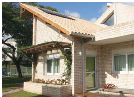
Figura 4: Proteção por meio de pergolado com vegetação na parede leste. Projeto Casa Eficiente. Florianópolis (CASA EFICIENTE) Foto de LabEEE/UFSC (imagem cedida pelo autor).
