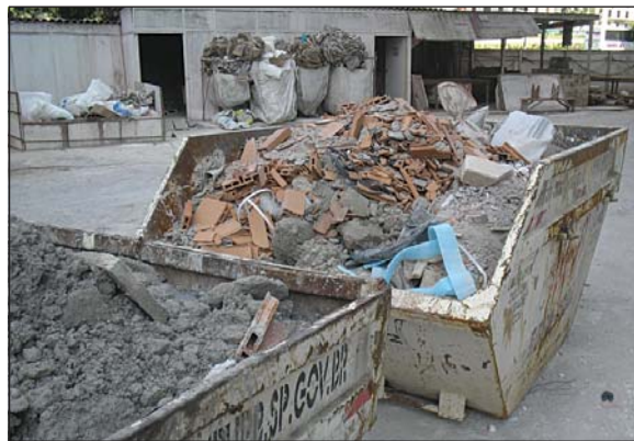
Figura 11: Exemplo de estoque central de resíduos em canteiro, alimentado pelos estoques dos andares. Observar o baixo índice de contaminação dos resíduos classe A, fruto de um programa de educação da equipe.
