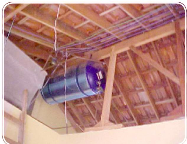
Figura 6 – Reservatório fixado na cumeeira do telhado.
