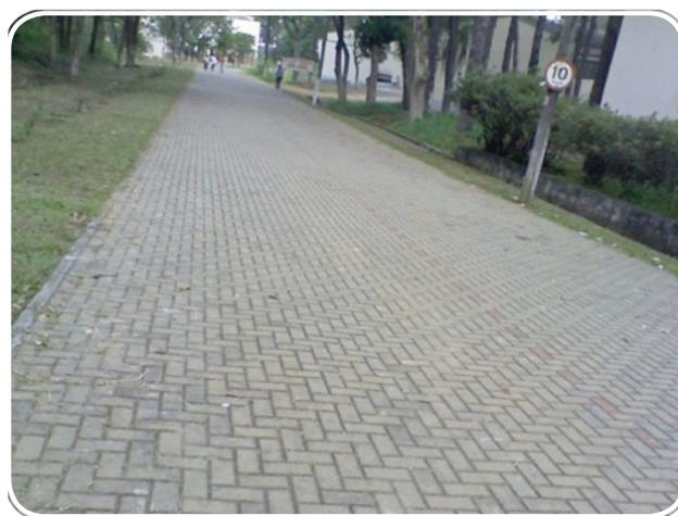
Figura 30 - Pisos permeáveis de blocos intertravados. Fonte: TECPAV (2010)
