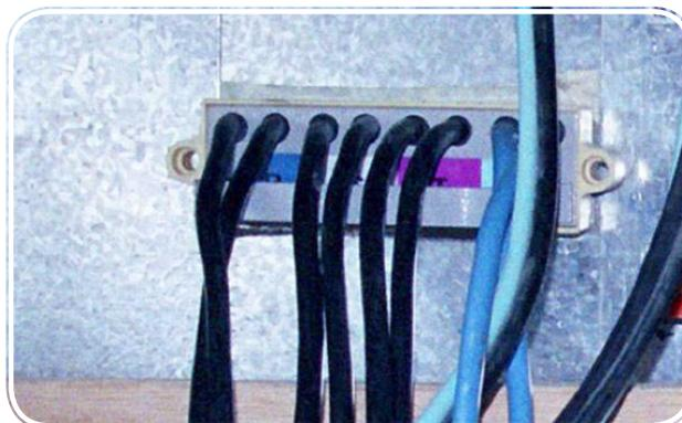
Figura 20 - Plug-in para conexão de barramento instalado. Fonte: CDHU (2005)
